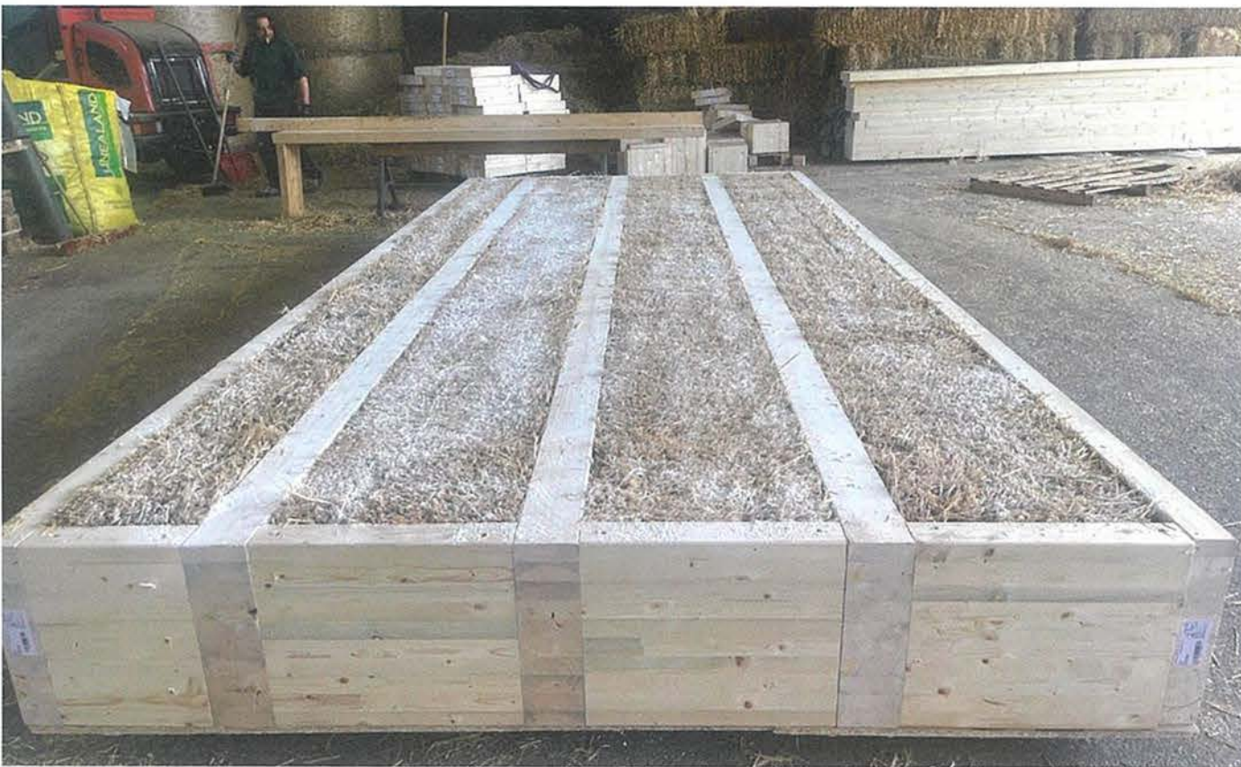
Riempimento cassoni con paglia compressa pre-trattata Filling bins with pre-treated compressed straw
