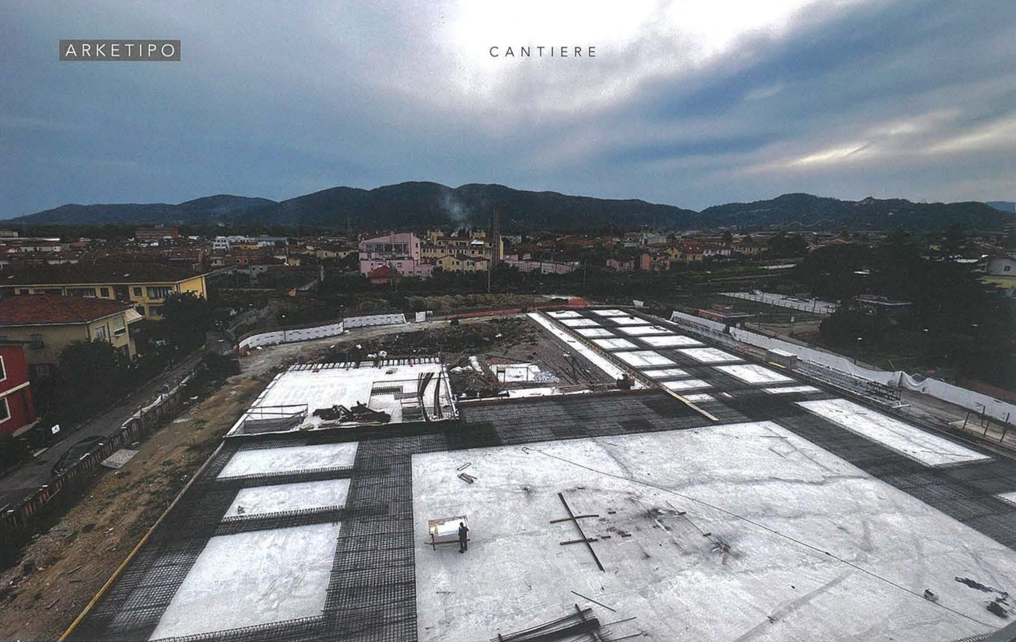
Costruzione delle fondazioni in c.a. e predisposizione dei cordoli
