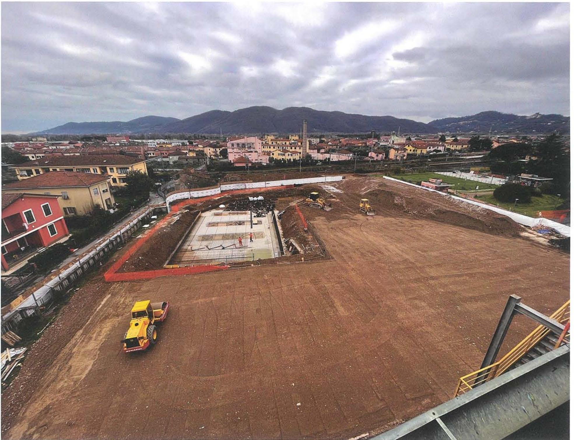
Fase di costruzione del rilevato in aggregato riciclato e prove di carico su piastra Construction phase of the recycled aggregate embankment and plate load tests
