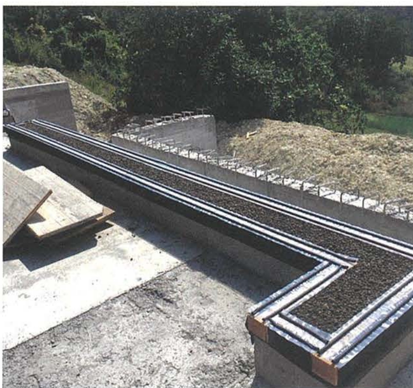
Costruzione delle fondazioni in c.a. e predisposizione dei cordoli
